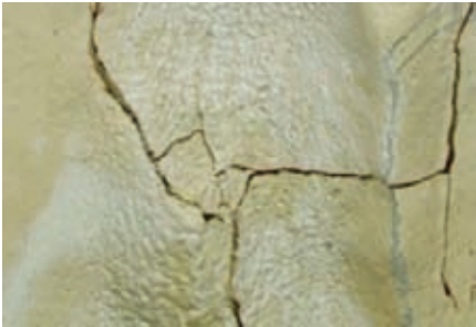
Confluencia de grietas en genitales del Cristo
